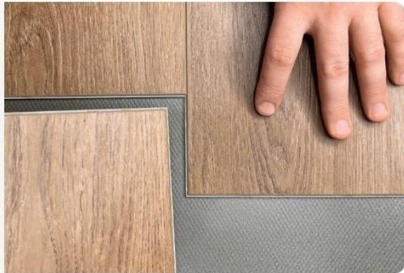
Устраните дефекты и трещины на основании. При необходимости с помощью скребка удалите старые следы клея и зачистите поверхность. Убедитесь, что черновой пол сухой, ровный, твердый, чистый и не содержит следов жира и химических веществ. Перед монтажом тщательно соберите весь мусор, подметите и пропылесосьте пол. Основание должно быть устойчивым, жестко зафиксированным.
