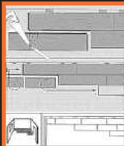
Подготовка последнего ряда. До начала укладки вы уже рассчитали ширину последнего ряда, скорее всего, вам придётся обрезать доски по ширине. Перед обрезкой измеряйте ширину элемента с двух концов, чтобы учесть неровности стен и нужный деформационный зазор 10 мм.
