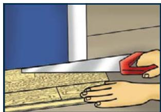
11. Дверные коробки можно снять и отставить в сторону, но их также можно подпилить. Используйте обрезок доски в качестве шаблона для отметки линии отреза. Подпишите дверную коробку мелкоузубчатой пилой. Заведите доску под коробку. См. также пункт 10.
