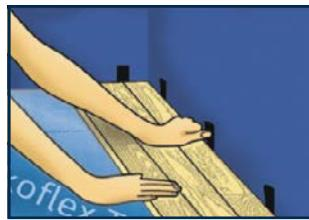
2. Первый ряд. Помните, что доски предпочтительно укладывать по длине комнаты. Начинайте укладку с угла, расположенного по левую руку, двигаясь вправо. Уложите первую доску стороной с пазом к стене. Расположите торец следующей доски под углом, затем, надавив, соедините торцы. Между напольным покрытием и стеной установите распорки для создания компенсационного зазора 8-10 мм.
